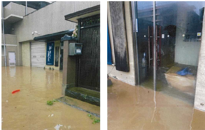
浸水被害の例
