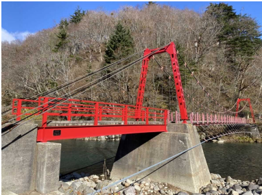
鳥海国定公園 【国】法体の滝園地吊り橋改修 (由利本荘市)
