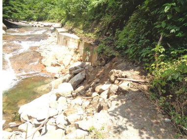
森吉山県立自然公園 【県】安の滝歩道改修 (北秋田市)
