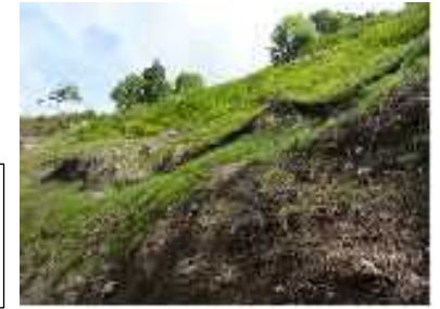
十和田八幡平国立公園 【国】玉川温泉道路(歩道)改修 (仙北市)
