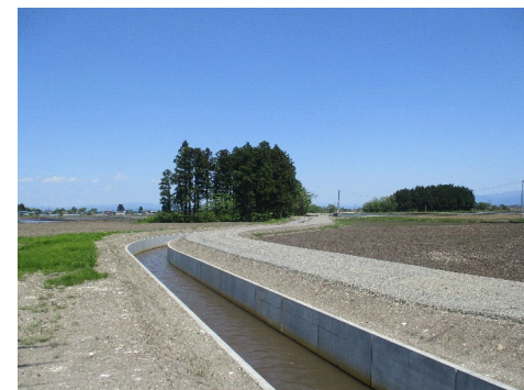
〔排水路の整備〕
