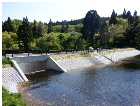
〔ため池の改修〕
