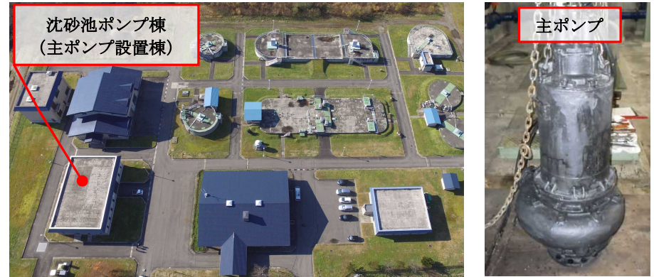
鹿角処理センター（鹿角市） 主ポンプ設備
