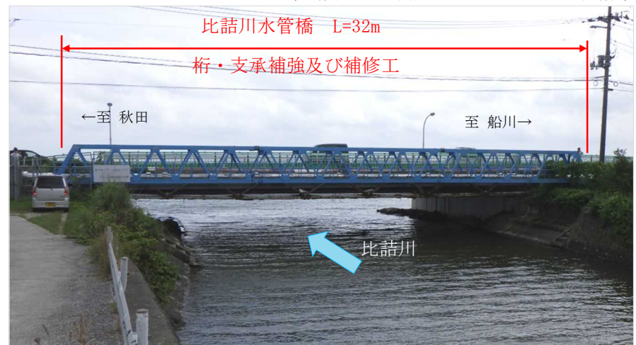
臨海処理区 男鹿幹線 比詰川水管橋（男鹿市）
