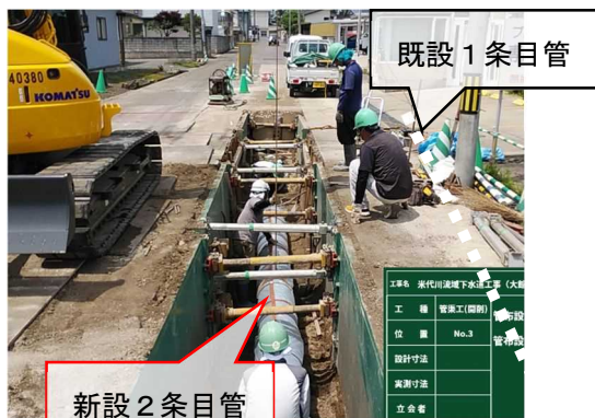
管路施設の2条化（大館市）
