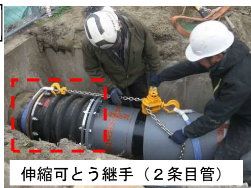
管路施設の耐震化（井川町）
