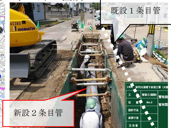
大館幹線 2条目管新設
