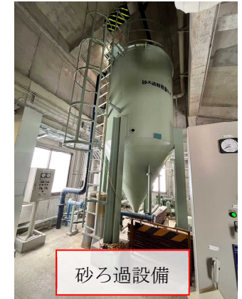
鹿角処理センター（鹿角市）砂ろ過設備 平成6年設置（29年経過）
