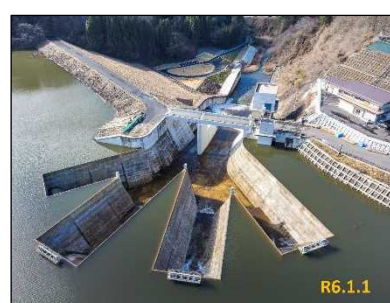
試験湛水状況
