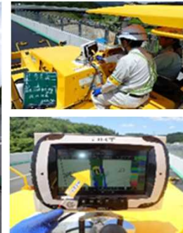
タイヤローラ転圧回数をヒートマップで確認
