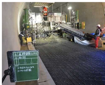
トータルステーションによるコンクリート打設
