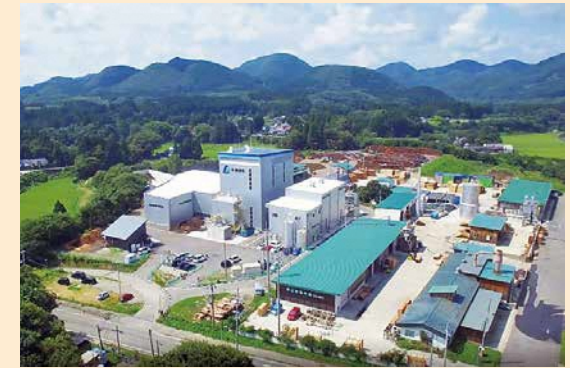
木質バイオマス発電施設(大仙市)
