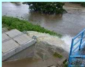
ポンプによる排水の様子
