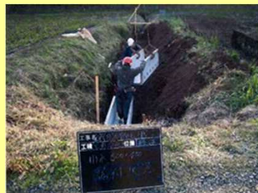
自主施工の実施
