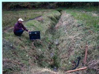
老朽化水路の確認
