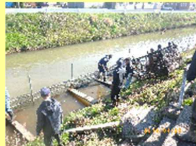
構成員によるポンプ等の点検・確認
