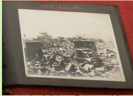
大仙市 (関東大震災の写真)
