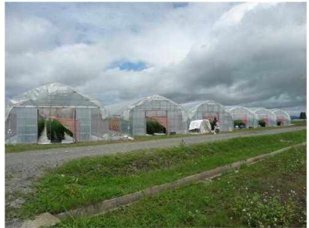
【トマトハウス遠景】
