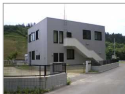
大内ダム管理棟
