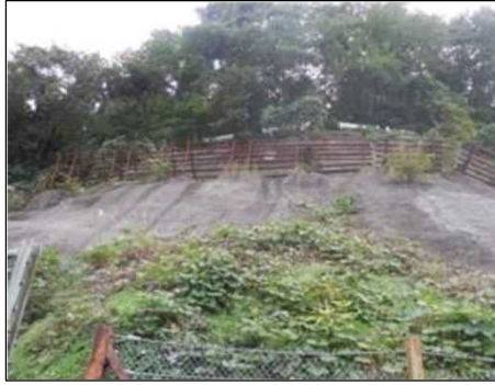
令和2年度 工事施工前
