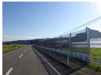
防雪柵 設置状況
