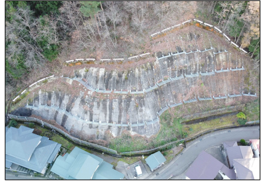
令和2年度 工事完成後（吊り柵工）
