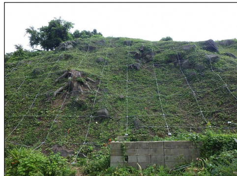
令和2年度 工事完成後（落石予防網工）
