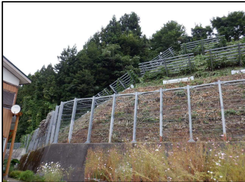
令和2年度 工事施工前
