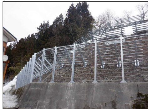
令和2年度 工事完成後 （落石防護柵・吊り柵工）
