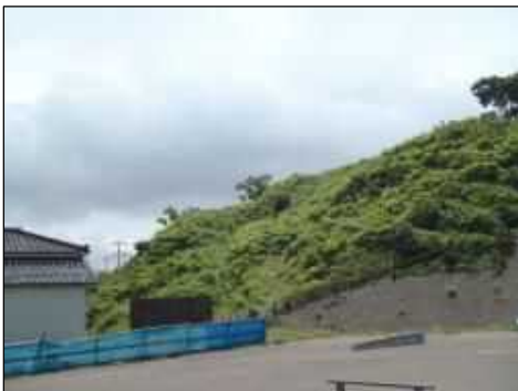
令和元年度 工事施工前
