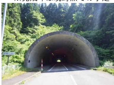
田代峠トンネル
