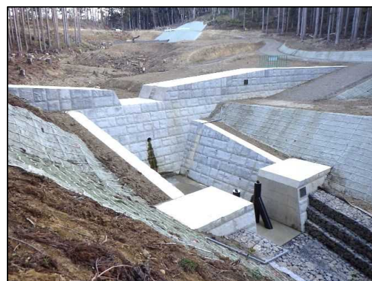
滝ノ沢2 砂防えん堤 R5. 3月時点
