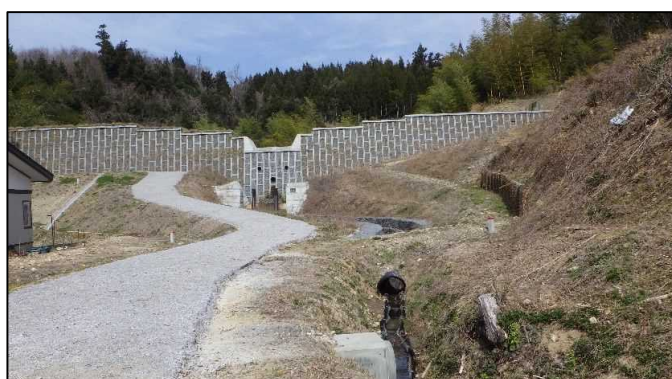
滝ノ沢5 砂防えん堤 R5. 3月時点
