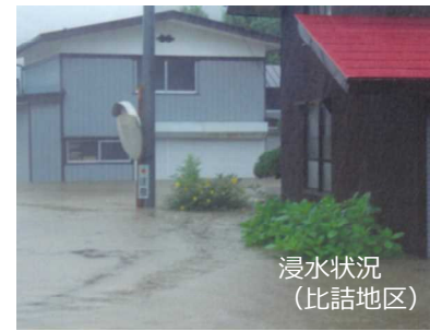
道路冠水状況
