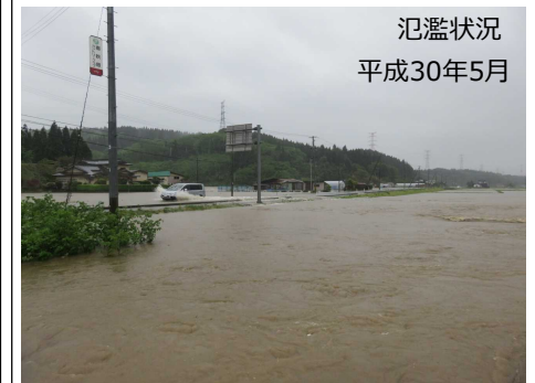
出水による被害状況
