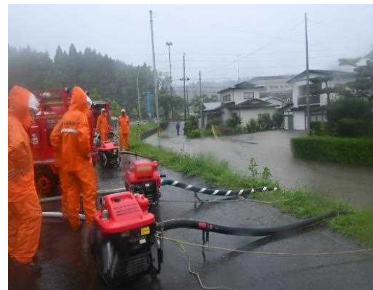
浸水被害における排水作業
