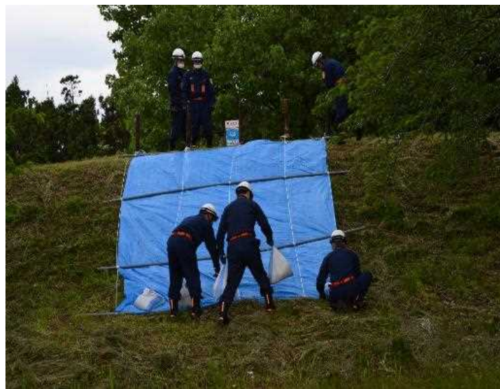
水防活動（土のう設置訓練）
