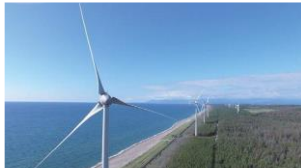
風の松原風力発電所(能代市)
