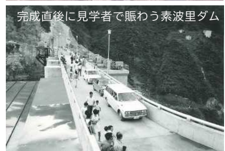
完成直後の素波里ダム全景
