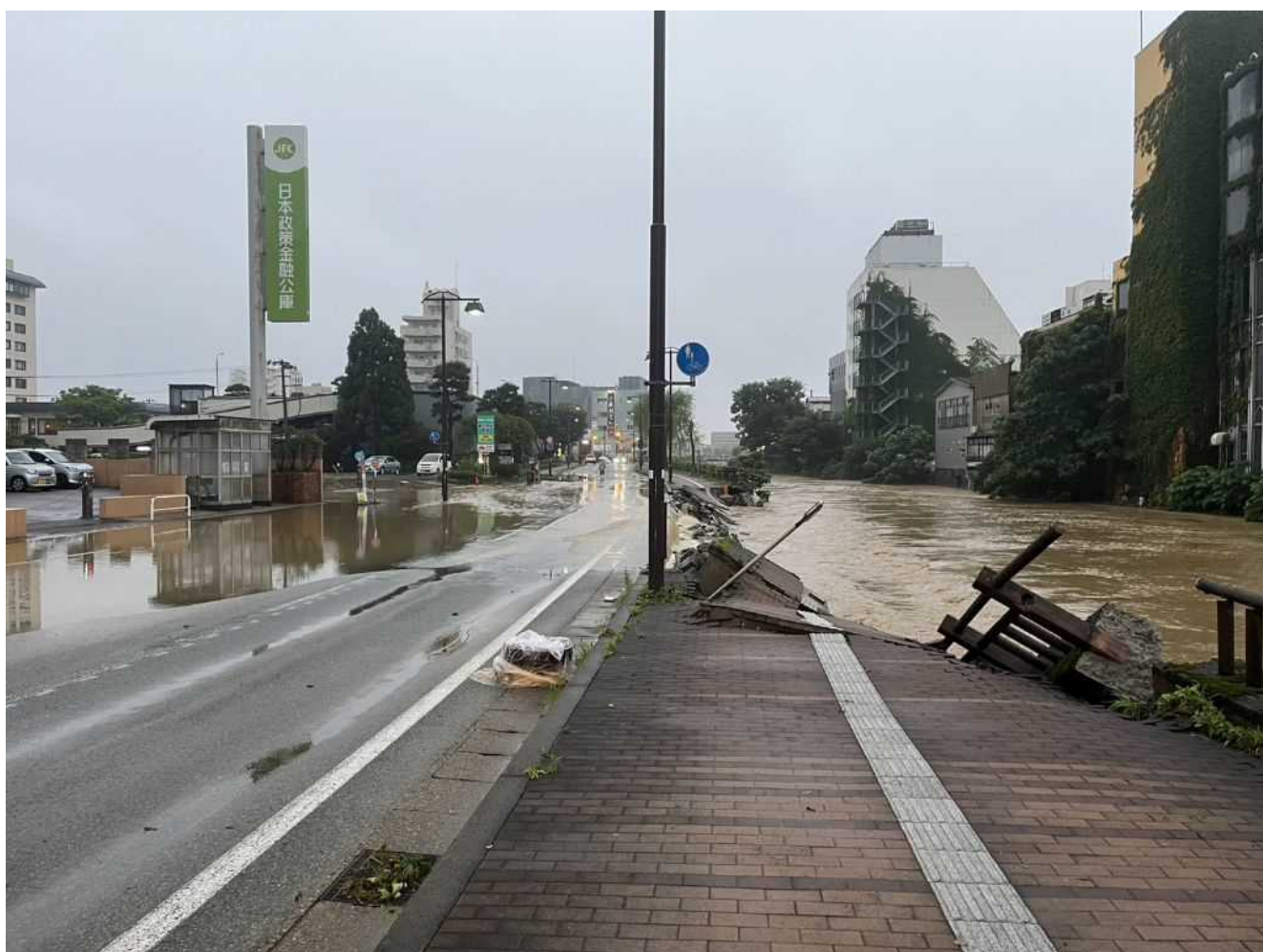
秋田岩見船岡線（旭川沿い）の歩道崩落（秋田市中通）
