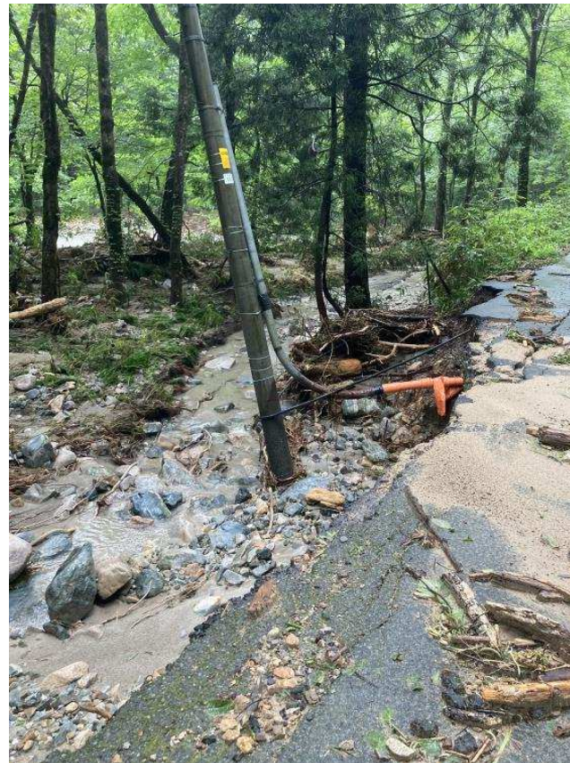
仁別林道の状況
