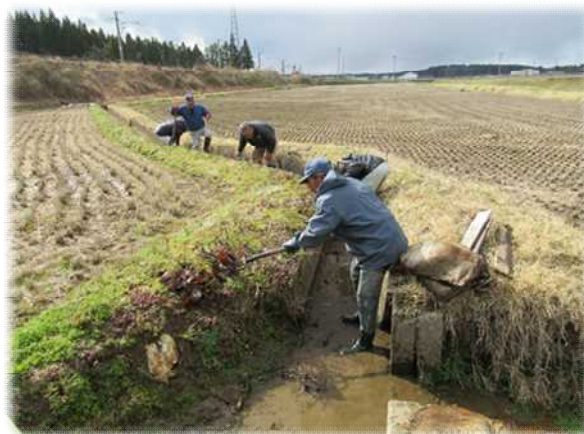
水路の泥上げ
