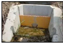
【流量調整板設置状況】
