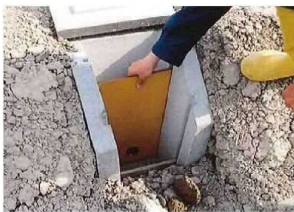
(流量調整板の設置状況)
