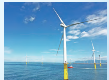
能代港洋上風力発電所 (写真提供：秋田洋上風力発電㈱)
