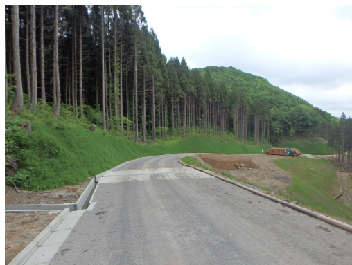
林道 峰浜線 八峰町 幅員 5.0m 開設延長 852m
