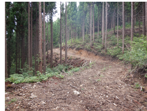
森林作業道 ヤセ長根線 横手市 幅員 2.5m 開設延長 914m
