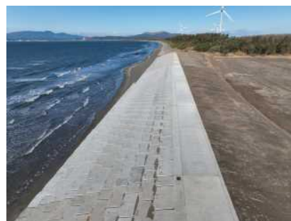
【防潮堤による海岸浸食防止対策】
