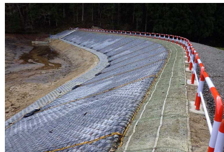
【ため池の安全ネット設置事例（仙北市）】
