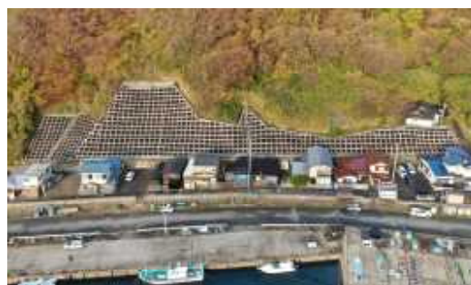
【モルタル吹付法枠工による機能強化対策】
