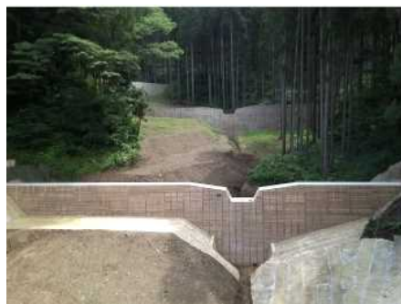
【治山ダム工による溪流の安定対策】
