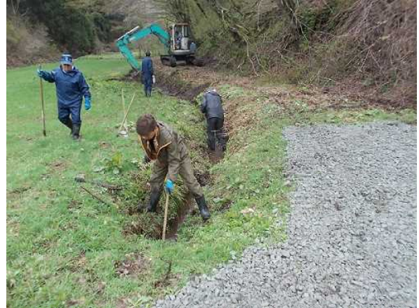
〈図〉農業用水路の土砂上げ作業
