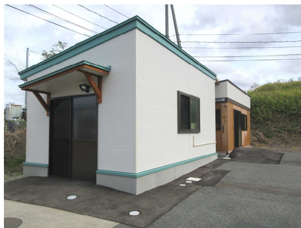
＜図＞漬物製造施設の整備
