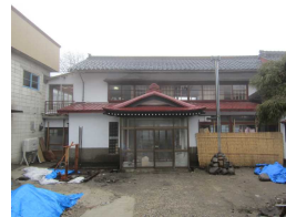
改修中のゲストハウス
