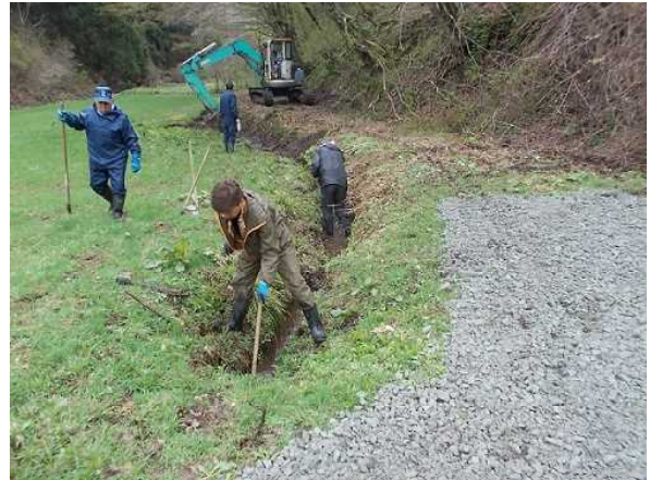
〈図〉農業用水路の土砂上げ作業
