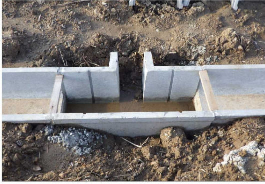
取水部水口工を下げた施工例
