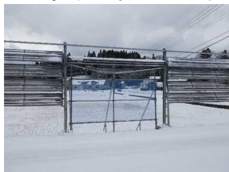
防雪柵の老朽化 (常盤峰浜線 能代市)
