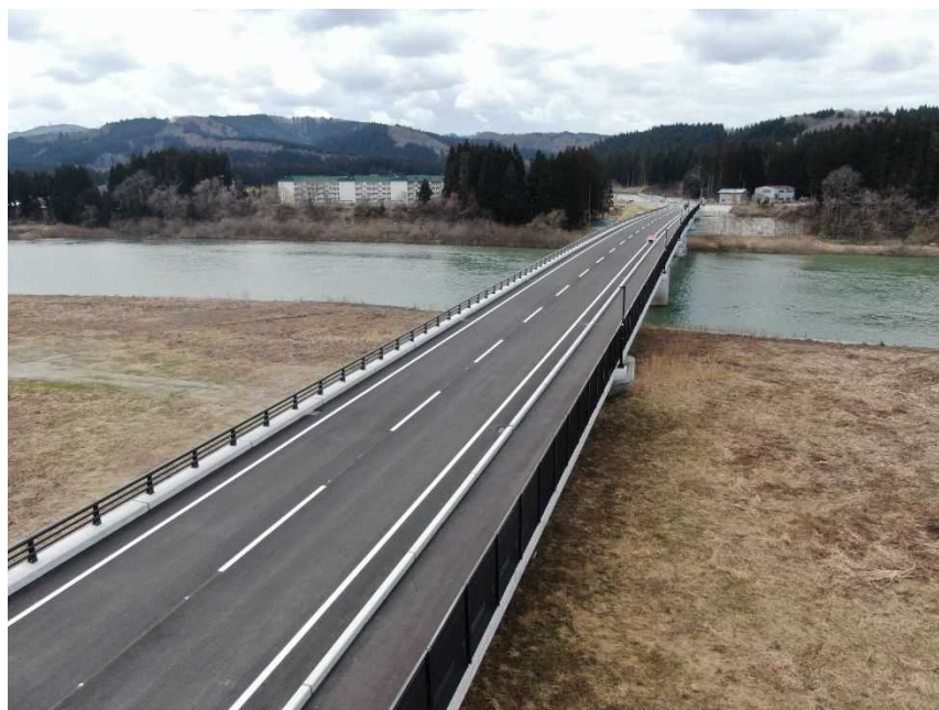
秋田雄和本荘線 相川工区（水沢橋） 完成 （秋田市・令和5年3月）
