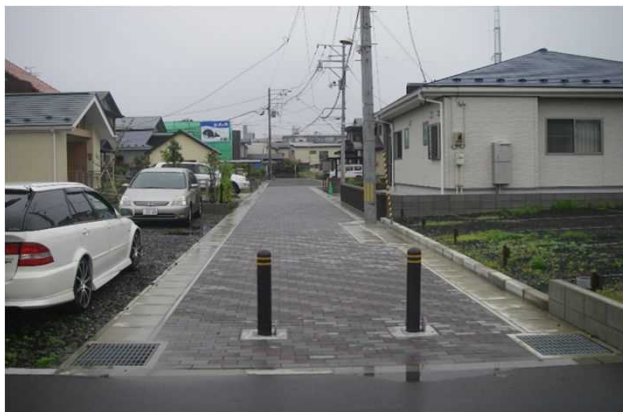
住宅市街地総合整備事 (秋田駅東第三地区 道路整備)
