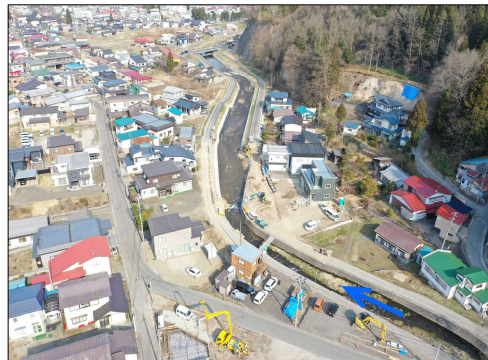
福士川(鹿角市) 《河道掘削・護岸工事》
