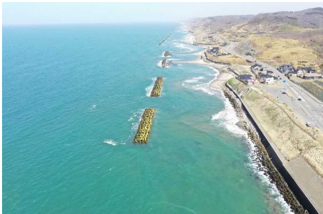
《離岸堤設置により侵食被害から県土を守る》 (本荘海岸(深沢地区) 由利本荘市)
