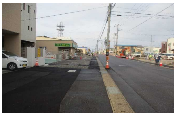
【進捗状況】 停車場栄町線(由利本荘市)
