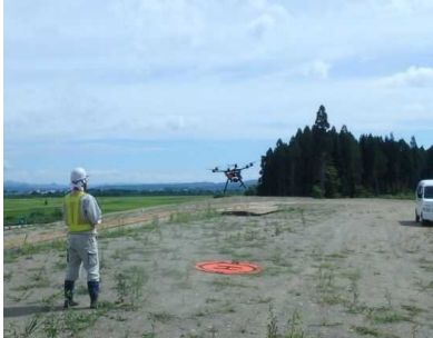
UAVによる起工測量状況
