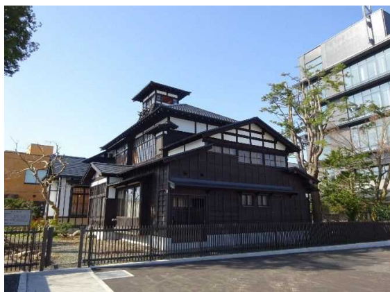
大館城下町地区 (歴史的風致形成建造物整備)
