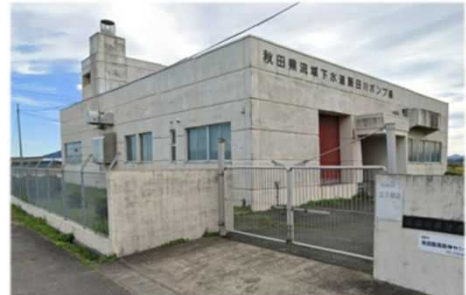
【臨海処理区 飯田川中継ポンプ場耐震化】
