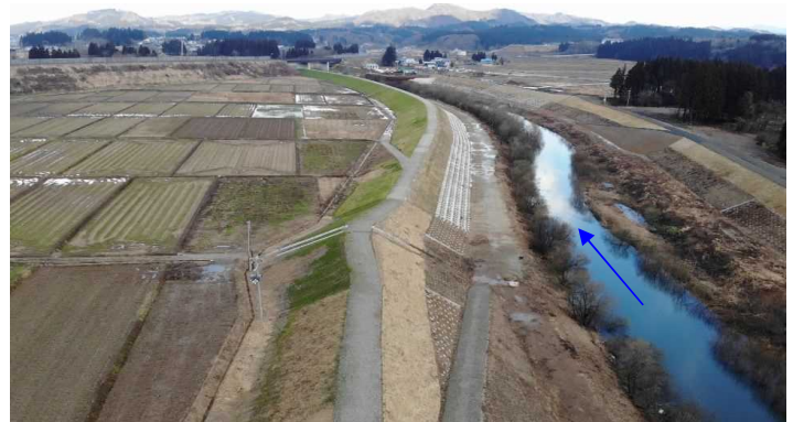
復旧工事完了
