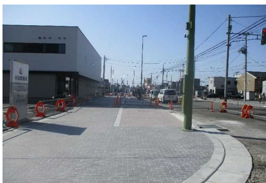
【進捗状況】 川尻広面線(秋田市)
