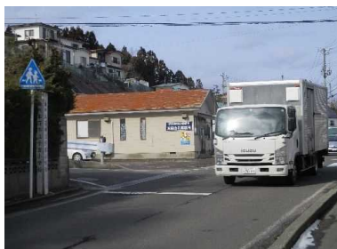
▲現況（歩道未設置）
