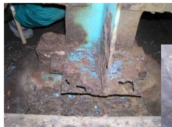
▲主桁及び支承部の腐食状況
