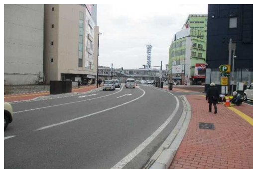
【歩道設置、道路拡幅による両側交互通行及び無電柱化 による安全安心な街路空間を確保】
