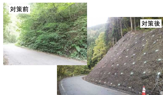
法面保護工((-)河辺阿仁線)
