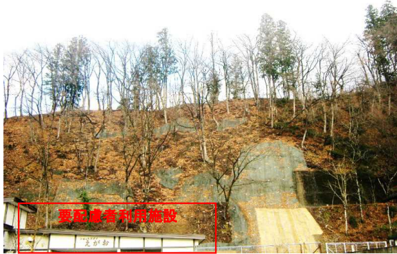
《要配慮者利用施設や市道をがけ崩れから守る法面工》 《横手市・愛宕地区》
