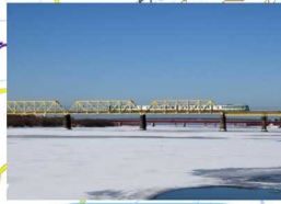
⑥米代川桥梁 (五能線)
