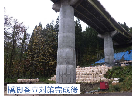
橋脚の耐震補強事例
