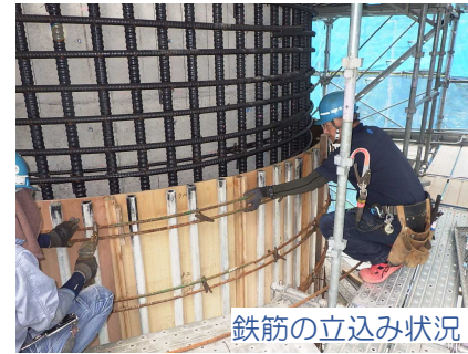
橋脚の耐震補強事例
