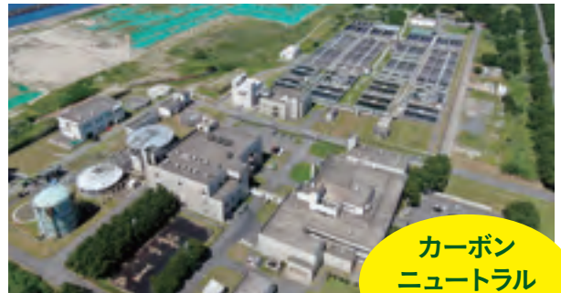
秋田臨海処理センター(下水処理施設)
