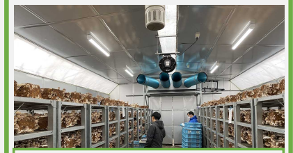
ヒートポンプを利用した しいたけ栽培施設
