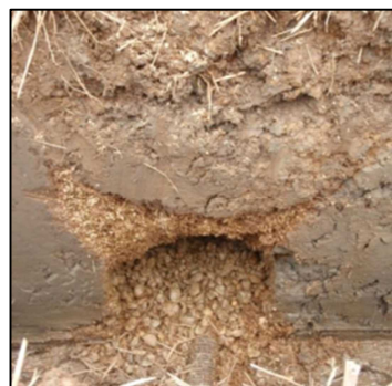
吸水管の断面形状
