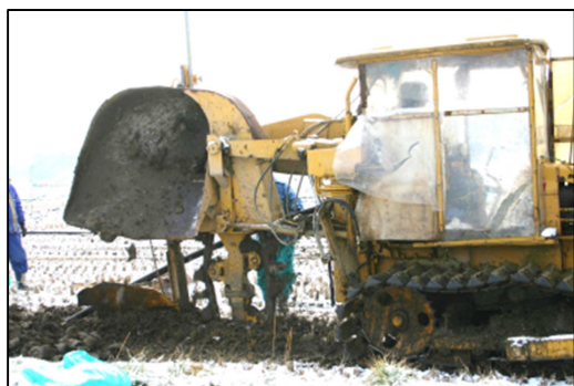
トレンチャーによる吸水管の造成
