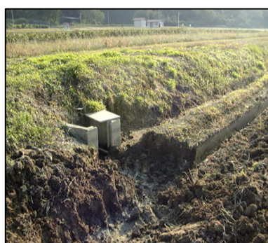
額縁明渠と落水口の接続
