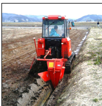
スクリーオーガー型 溝掘機による額縁明渠 の施工
