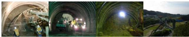
三坂トンネル 江ノ串トンネル 鈴田トンネル 千綿川橋りょう
