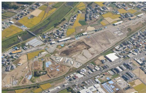
工事着手当初(2015年)
