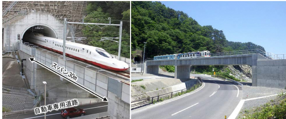
九州新幹線、原種架道橋
