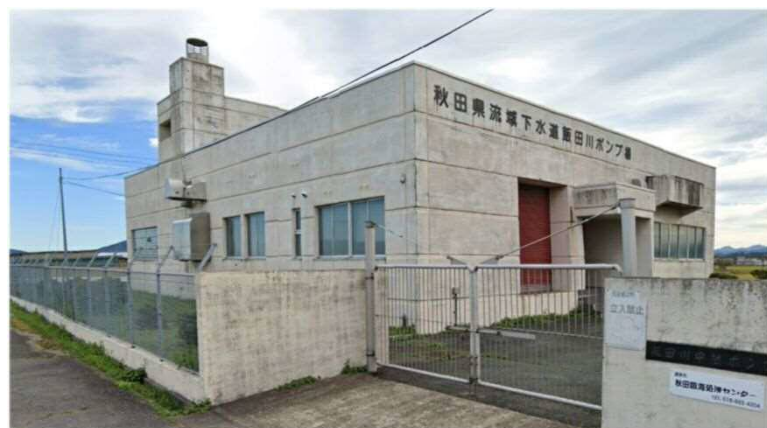
臨海処理区 飯田川中継ポンプ場（潟上市） 平成2年建設（32年経過）
