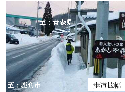
国道282号 苦竹工区 (小坂町)
