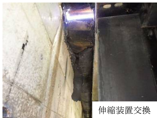
国道105号 芋川大橋 (由利本荘市)
