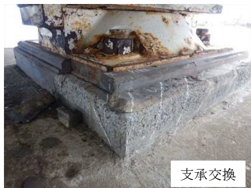
国道101号 能代大橋 (能代市)
