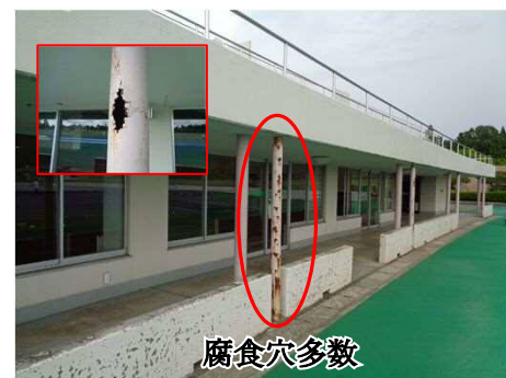
中央公園（秋田市） 【排水ドレン改修】
