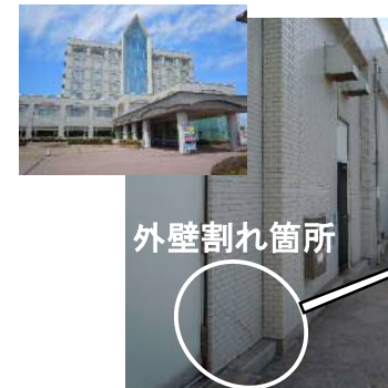
外壁タイルに割れ、浮きの発生状況
