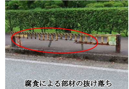
小泉潟公園（秋田市） 【ゲート改修】
