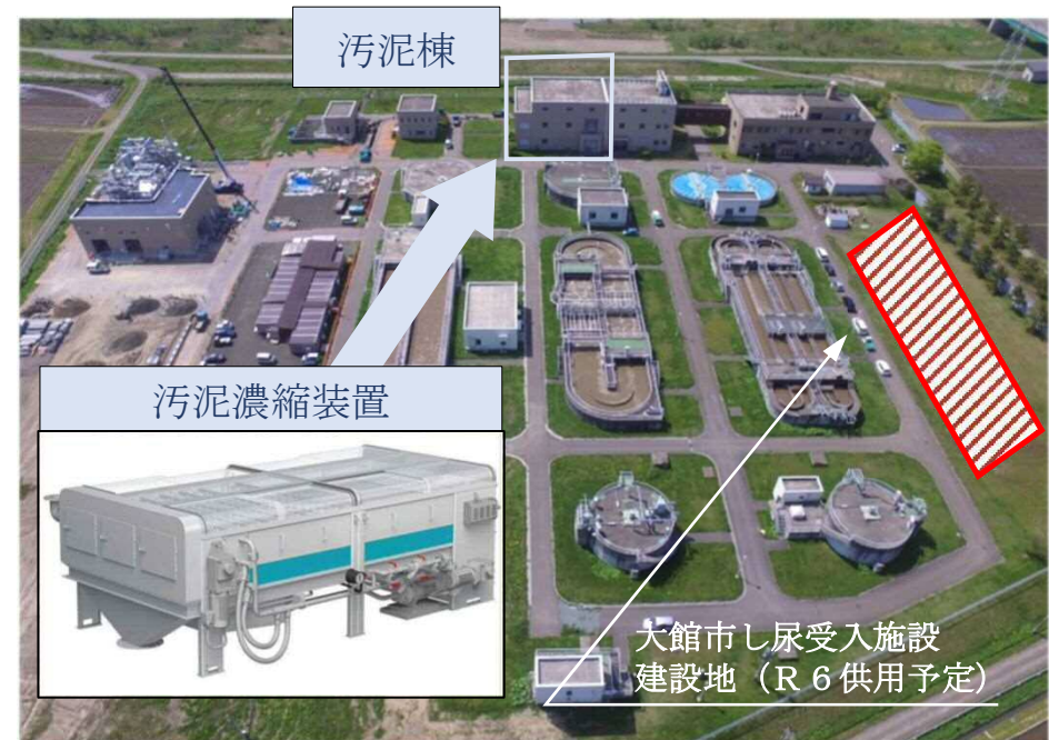
大館処理センター（大館市） 大館市し尿受入施設の建設に伴う汚泥濃縮設備の増設
