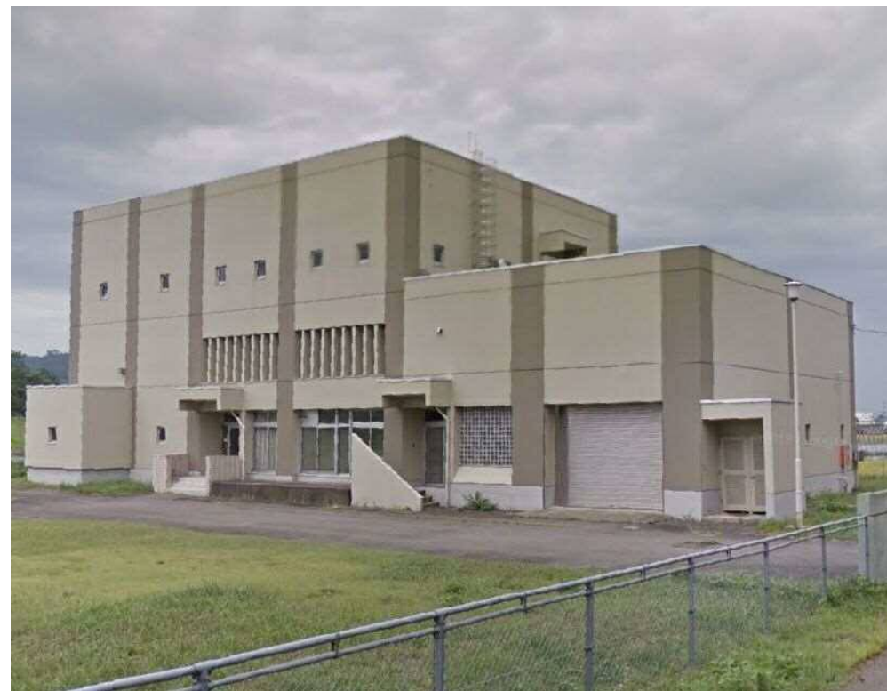
大曲処理区 大曲中継ポンプ場 (大仙市)
