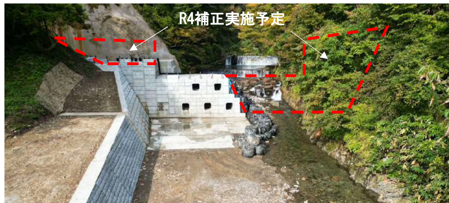
白山川（秋田市） えん堤工
