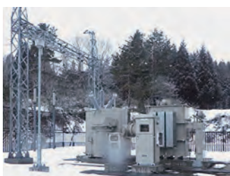
66kV受変電設備 県内水力発電所
