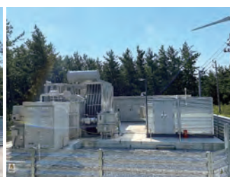
66kV受変電設備 県内洋上風力発電所
