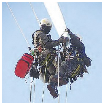
ブレード補修状況
