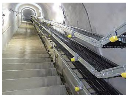
ケーブル敷設工事
