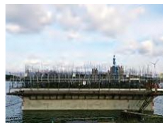
ケーソン内足場
