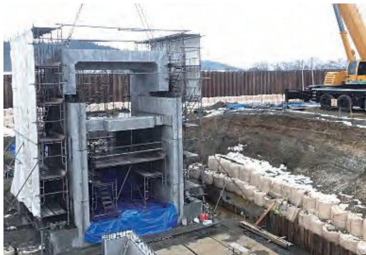
プレキャスト排水樋門施工
