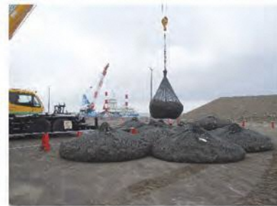
洗堀防止工での石材出荷
