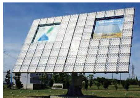
集光式太陽光発電追尾システム
