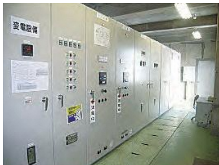
受変電設備工事
