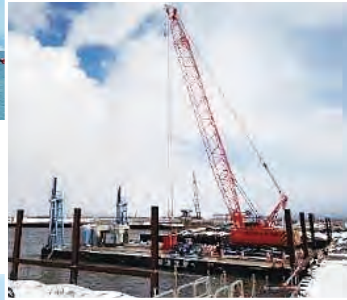
70t吊りクレーン搭載組立台船 (ユニフロート)
