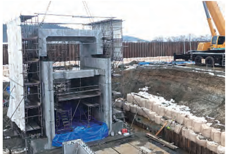
プレキャスト排水樋門施工
