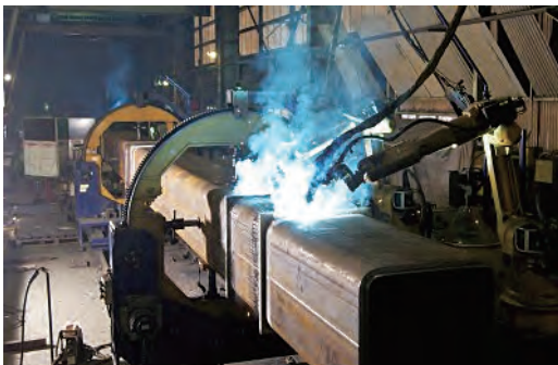
最新鋭のロボット溶接システムによる溶接作業
