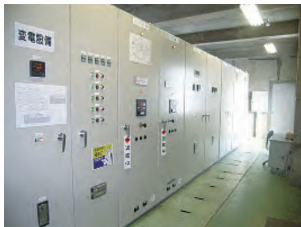
受変電設備工事
