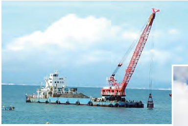
100t吊り起重機船
