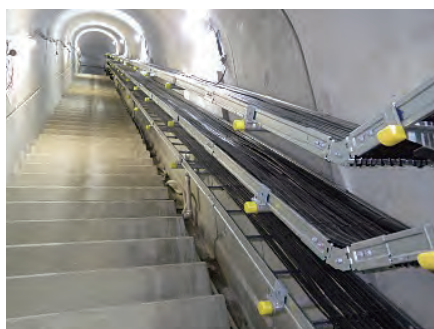
ケーブル敷設工事
