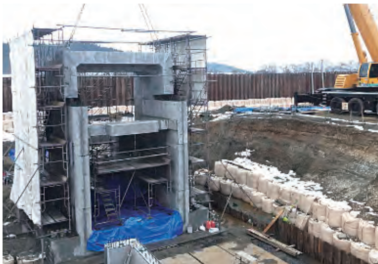
プレキャスト排水樋門施工
