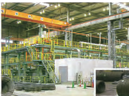
自動酸洗設備
