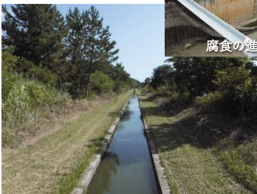
現況の幹線用水路
