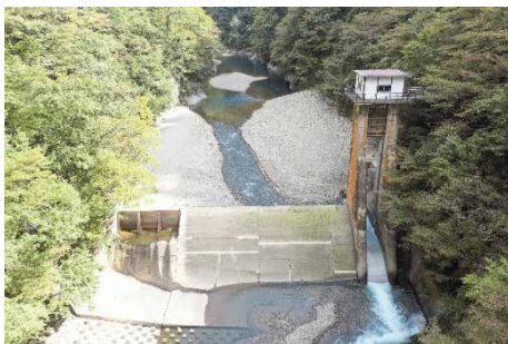
抱返頭首工（改修中）
