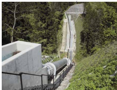
第二田沢幹線用水路（施工後）
