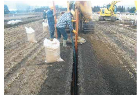
暗渠排水の整備
