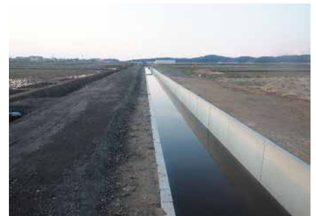
排水路の整備
