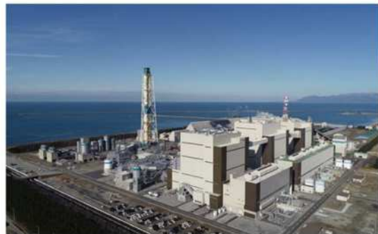
能代火力発電所
