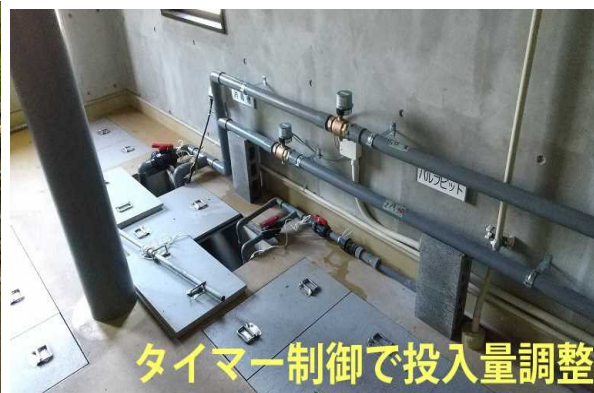
下水再生水の投入実験
