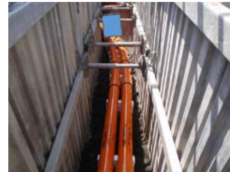
管路工事(据付)
