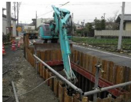
管路工事(掘削)
