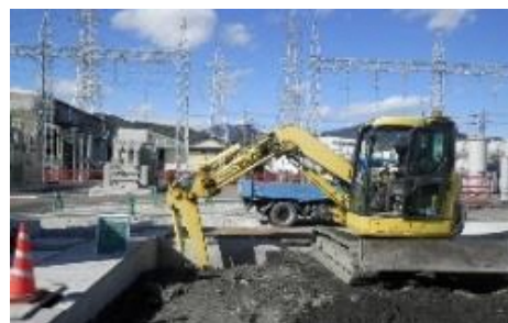
変圧器基礎工事
