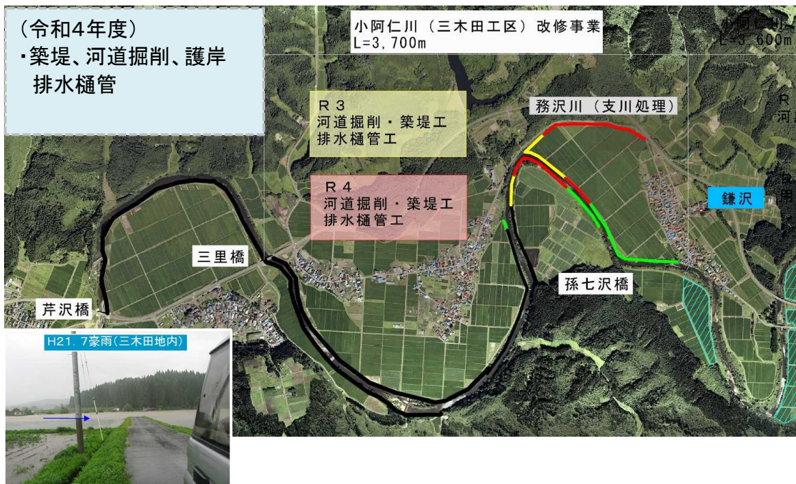
小阿仁川 三木田工区(築堤完成)
