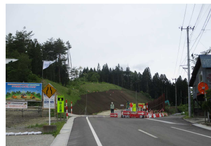
◆ 矢坂糠沢線の斜面開削の様子
