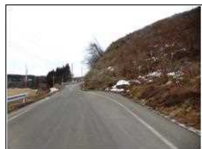
◆ 矢坂糠沢線の狭隘部
