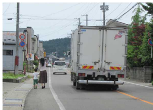
◆沖田面地区の現道状況
