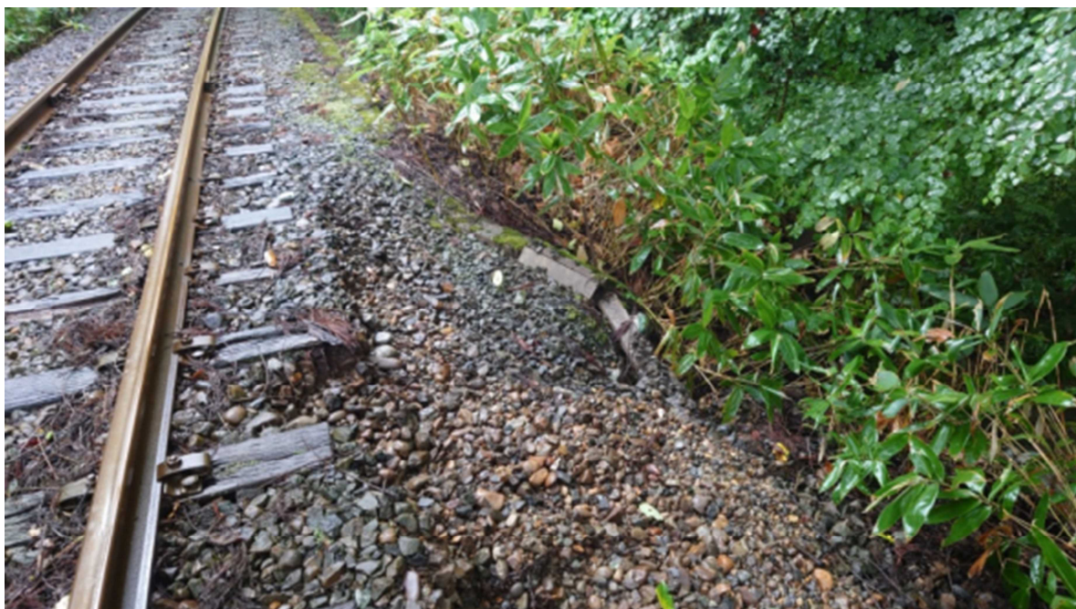
○ 米内沢～桂瀬間 20km 付近
