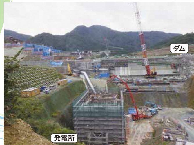
R4年度発電所地下1階コンクリート打設
