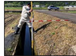
道路天端から水路底 H=1.9m 排水路 H=1,100×B=600
