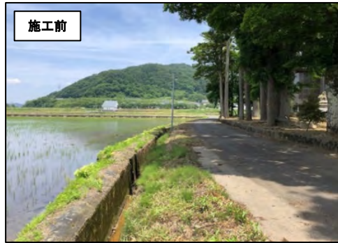
道路天端から水路底 H=1.9m 排水路 H=1,100×B=600
