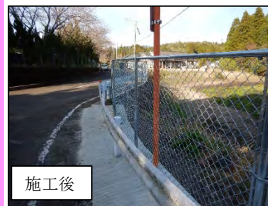
転落防止柵の設置
