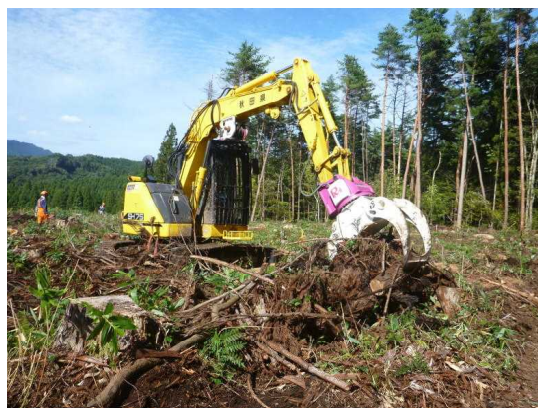
【一貫作業システムでの機械による地拵え実習】
