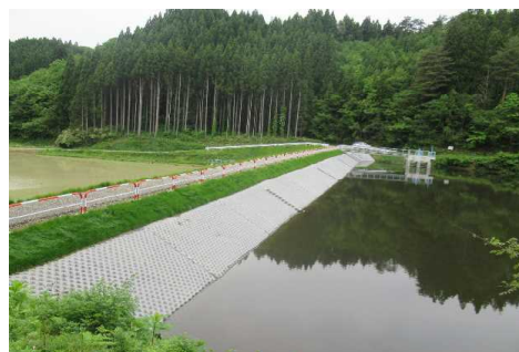
【改修工事が完了した潟上市 市ノ坪ため池】
