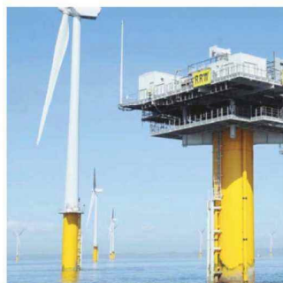
海上変電所建設及び送電線敷設 (電気設備は国内規格に準拠)
