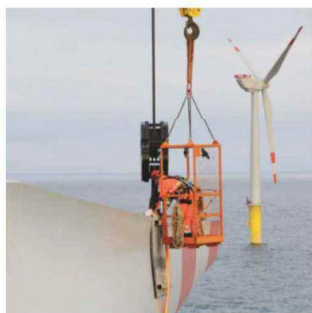
拠点港等の港湾整備・基地化、港駐在エンジニアによるO&M業務
